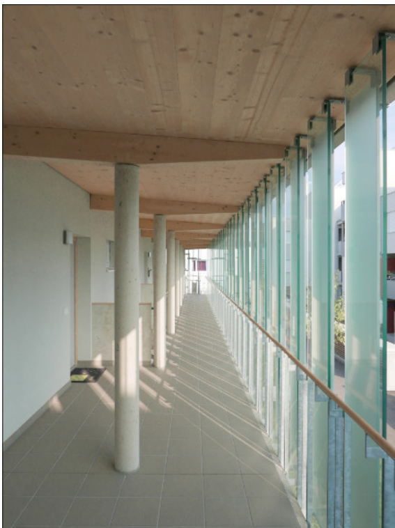
Grete-Bittner-Straße - geförderter Wohnbau Architektur: Eva Rubin (Fotografie von Christian Brandstätter)
