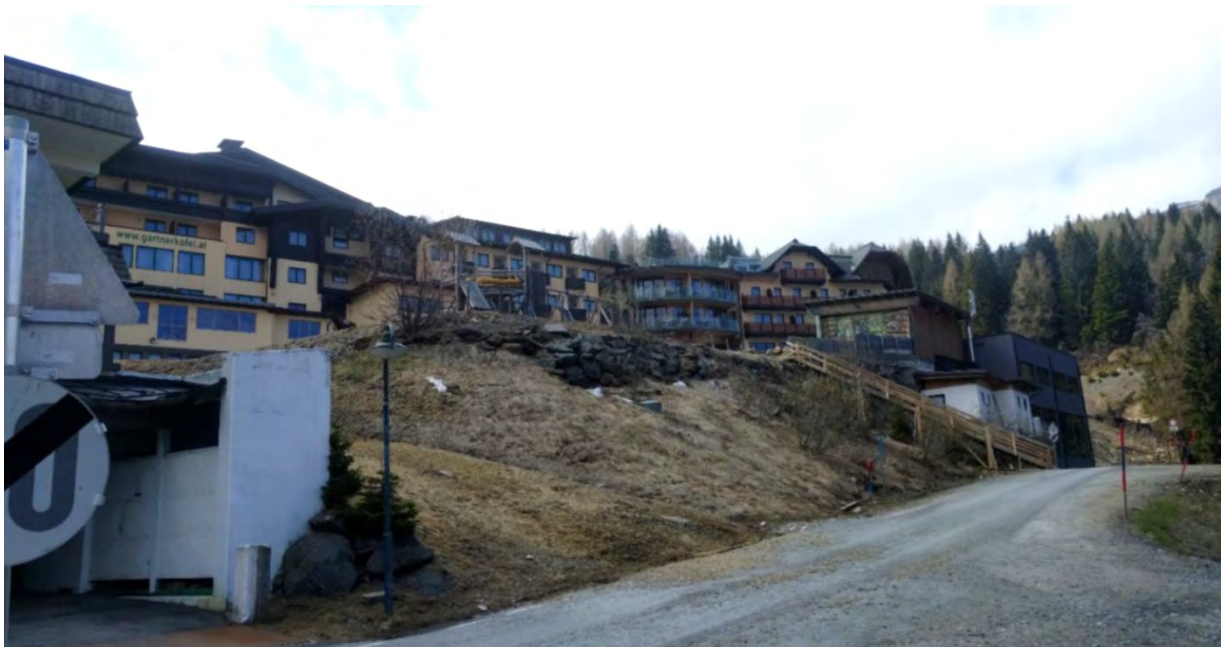
Abbildung 11: Ansicht vom Schlosserweg Richtung Süden (Quelle: LWK)
