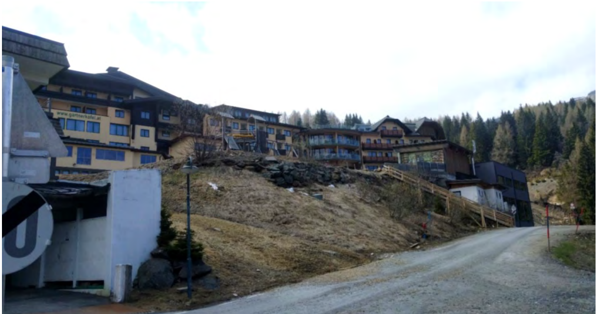
Abbildung 11: Ansicht vom Schlosserweg Richtung Süden (Quelle: LWK)
