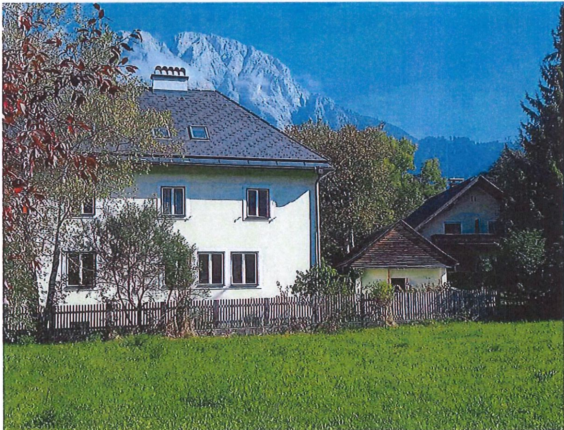
Haus Nr. 2 und Nr. 3 im Nordosten
