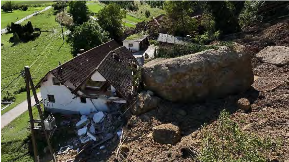
Abbildung 9: Felssturz in Rottenstein 1
