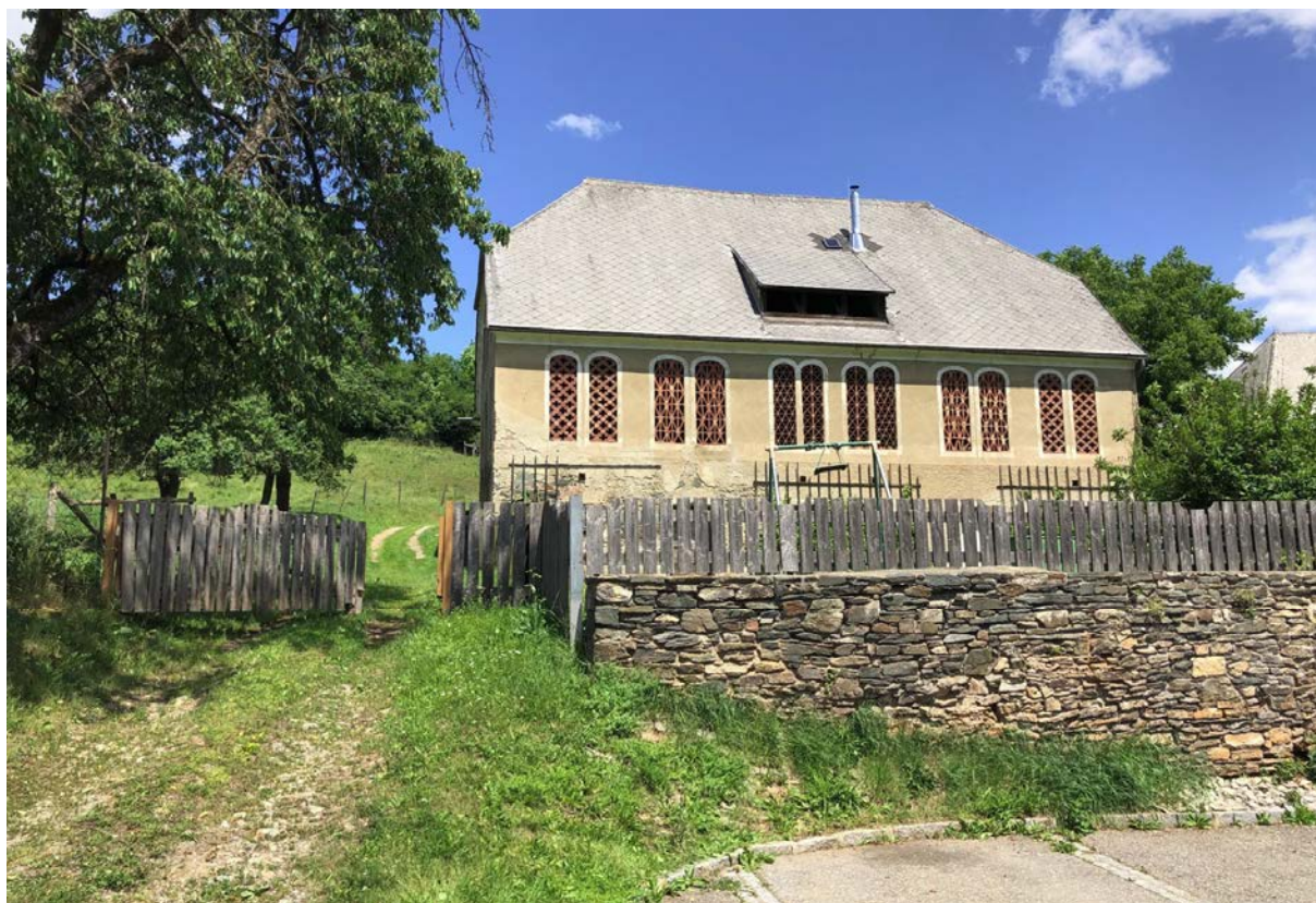
Foto 2: Blick vom Parkplatz Bestand nach Norden
