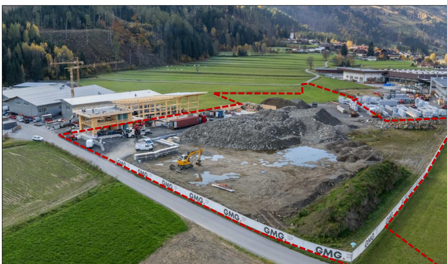
Blick auf das Projektgebiet mit dem in Bau befindlichem Bürogebäude (Quelle: GMG, Herbst 2024)
