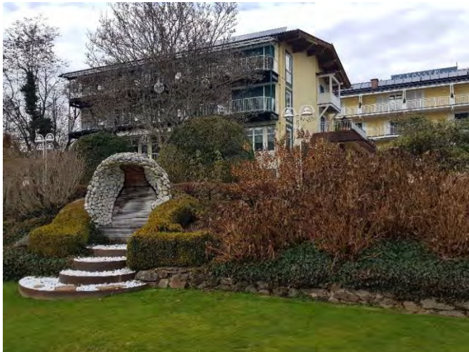
Abbildung 9: Hauptgebäude und 3-geschossiges Hotelgebäude von Süden
