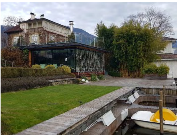
Abbildung 11: Saunagebäude, Blick nach Nordosten
