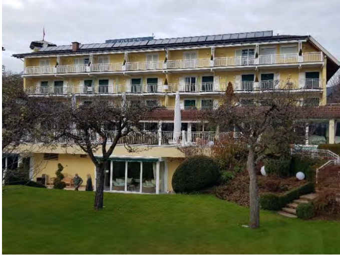
Abbildung 8: Ansicht Hauptgebäude von Süden
