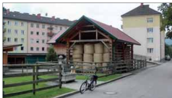
Wohnanlage Gailitzer Straße
