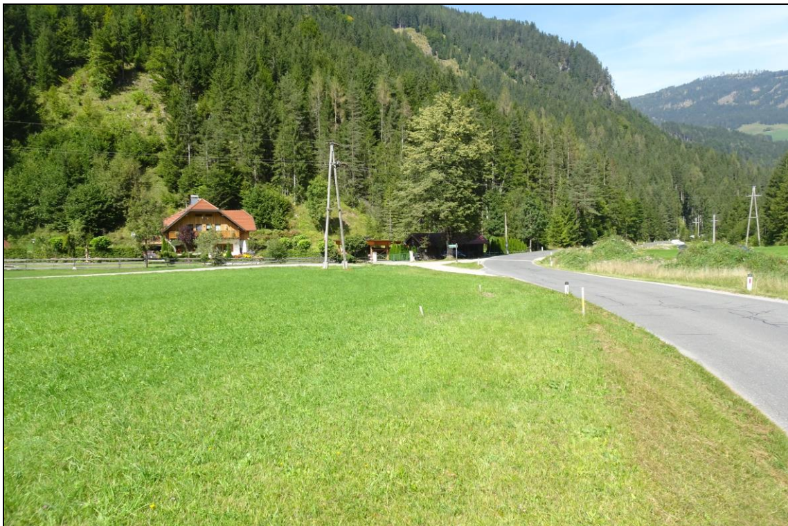
Foto 4 - Blick auf den nordöstlichen Planungsraum (von Süden)
