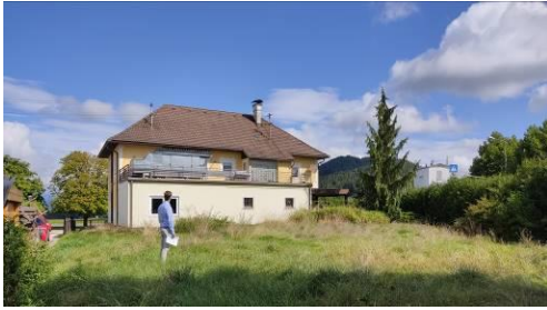
Südliche Fassade des Bestandsgebäudes mit eingeschößigem Flachdachanbau
