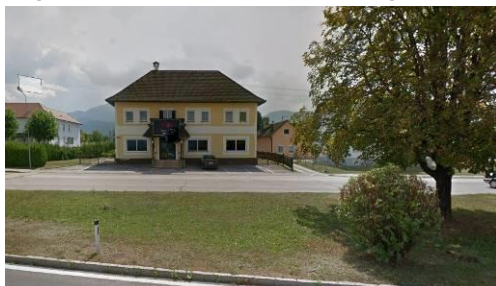
Bestandsgebäude von Norden betrachtet
