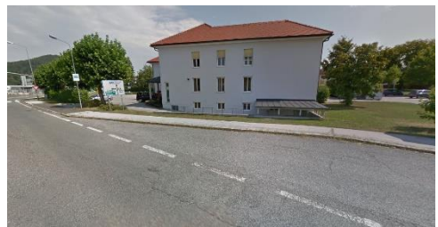
Nordwestansicht des Raiffeisengebäudes
