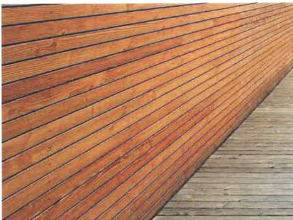
Fassade Innen (Holzlamellen Lärche)
