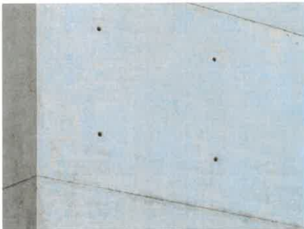
Fassade Nebenbereich (Beton)
