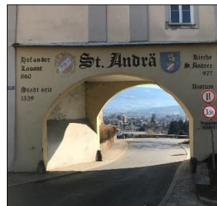
RESTE DER STADTBEFESTIGUNG VON LINKS: HAUS NR. 17, HANGKANTE, DURCHLASS RICHTUNG OSTEN
