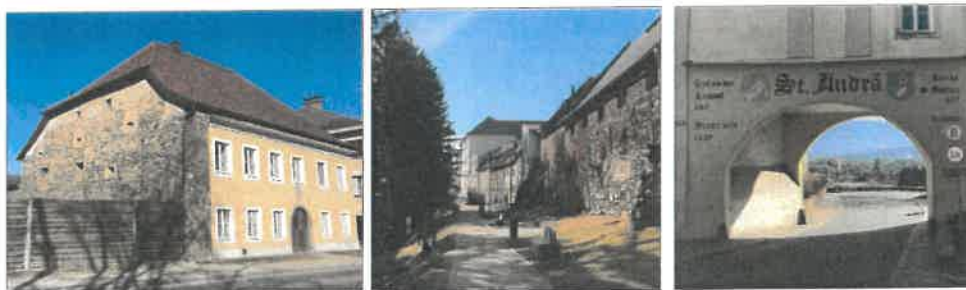
RESTE DER STADTBEFESTIGUNG VON LINKS: HAUS NR. 17, HANGKANTE, DURCHLASS RICHTUNG OSTEN
