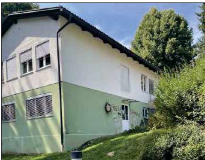
Abbildung 18: Servergebäude, dieses soll im Norden an das Hauptgebäude angeschlossen werden (Quelle: eigene Aufnahme)
