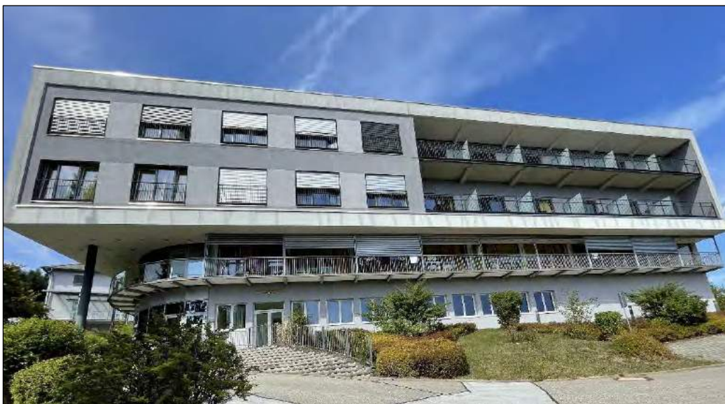
Abbildung 9: Hauptgebäude - Ansicht von Süden, im westlichen Teil des Gebäudes wird der Zubau erfolgen (Quelle: eigene Aufnahme)
