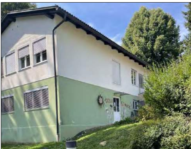
Abbildung 17: Servergebäude, dieses soll im Norden an das Hauptgebäude angeschlossen werden (Quelle: eigene Aufnahme)
