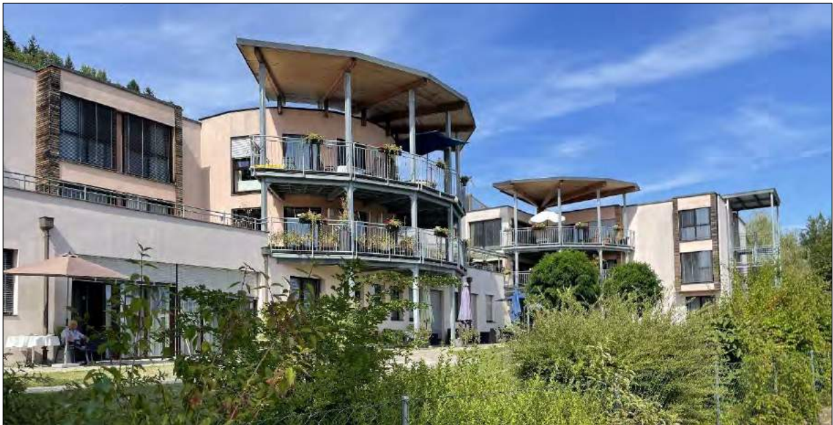
Abbildung 12: "Haus Abendruh" von Südwesten (Quelle: eigene Aufnahme)
