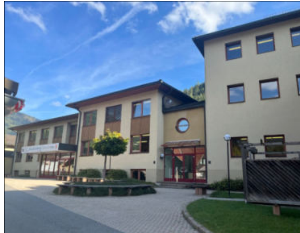
Mittelschule Nockberge - Patergassen (Quelle: ©Mittelschule Nockberge-Patergassen)
