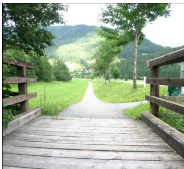
Fuß- und Radwegebrücke über die Gurk im Bereich der Ortschaft Waidach
