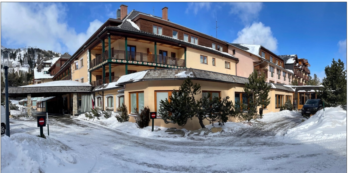
Eingangsbereich im Süden des Hotels (Quelle: RP-Büro Kaufmann)
